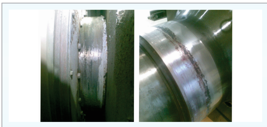
Figura 12: Suciedad en el eje del anillo rotativo.
